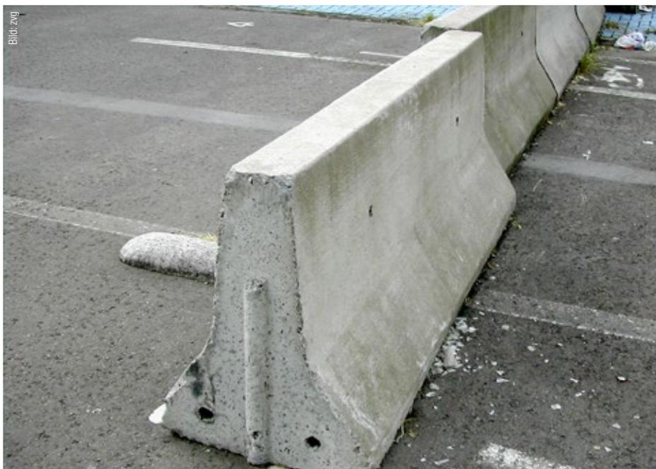
Die bekannten «New-Jersey-Elemente» sind bis zu 4,5 Tonnen schwer und in erster Linie dazu konzipiert, aus der Spur ausbrechende Fahrzeuge wirksam abzufangen und zurückzuleiten.
