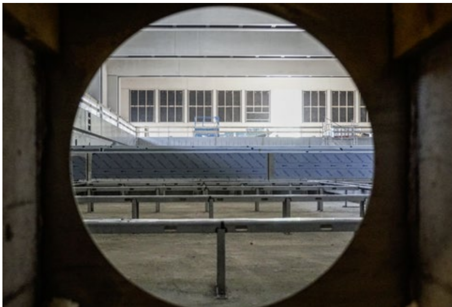
Einblick ins Olympiabecken durch ein «Bullauge»: Gut erkennbar ist die angebrachte Trägerkonstruktion.
