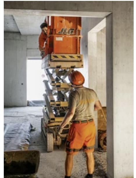
Bei den Ausbaurbeiten geht es teils hoch hinaus.
