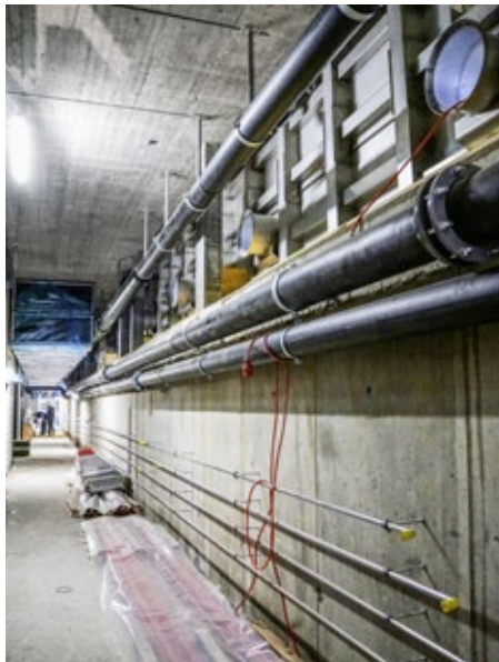
Die Oberwände des grossen Beckens sind montiert.
