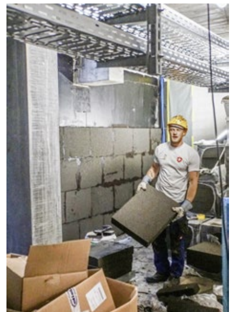
Unter Boden wird die Wärmedämmung eingebaut.
