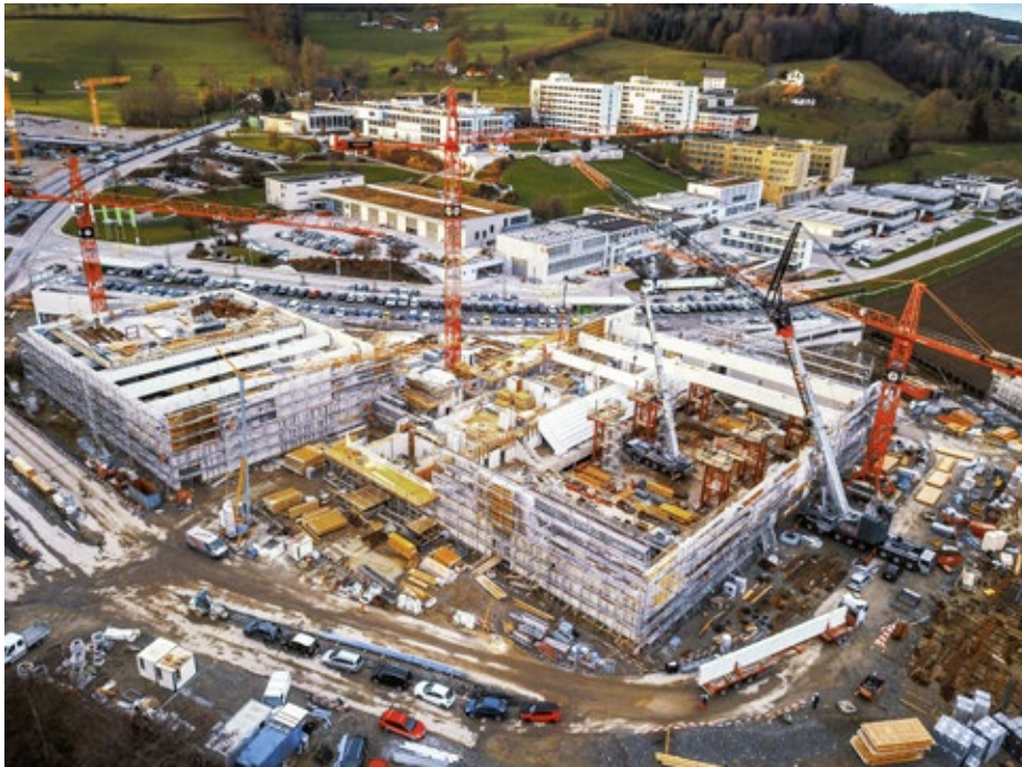
Sportarena-Baustelle im November 2017: Es entstehen die Dreifachsport- und Schwimmhalle (rechts).
