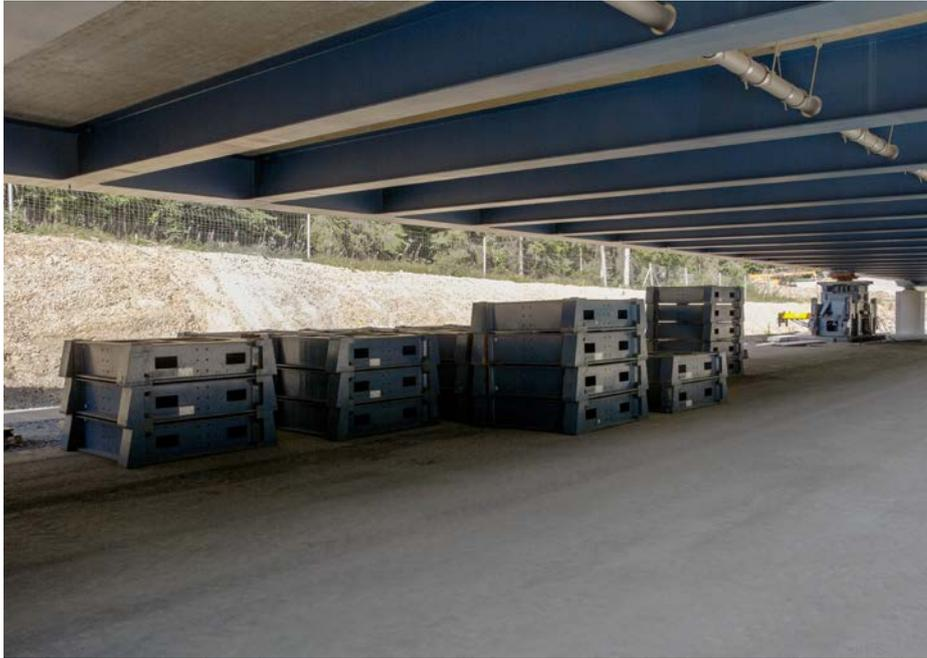
Je einer dieser schwarzen Füllkästen wurde in die Hydraulikpresse geschoben, wenn der Hubkolben seine maximale Höhe erreicht hatte. Dann konnte man den Kolben einfahren und einen neuen Hub beginnen. (Bild oben)
