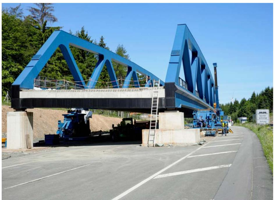
Beide Ersatzbrücken wurden auf der vollständig gesperrten Fahrbahn Richtung Giessen vormontiert.
