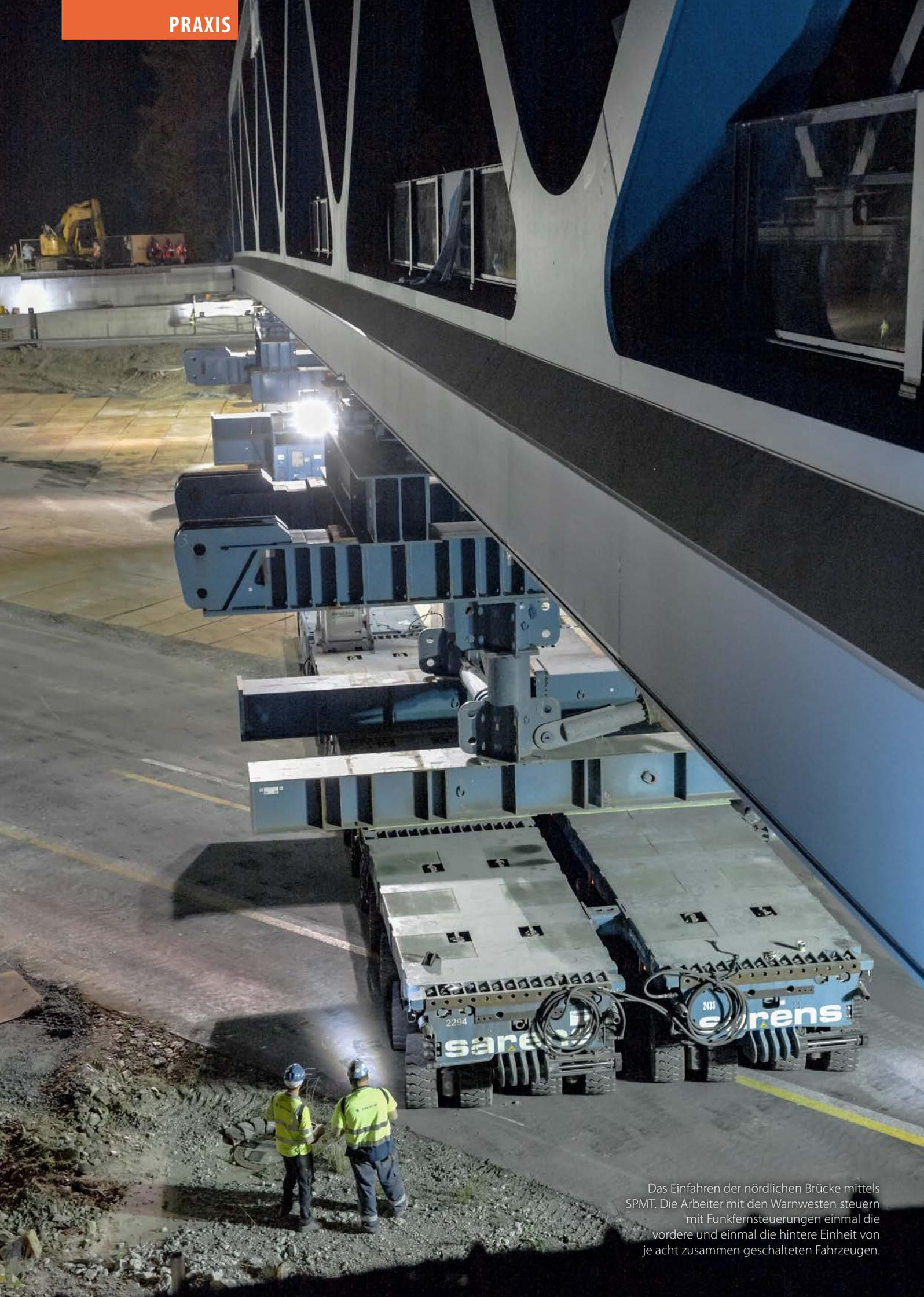
Das Einfahren der nördlichen Brücke mittels SPMT. Die Arbeiter mit den Warnwesten steuern mit Funkfernsteuerungen einmal die vordere und einmal die hintere Einheit von je acht zusammen geschalteten Fahrzeugen.
