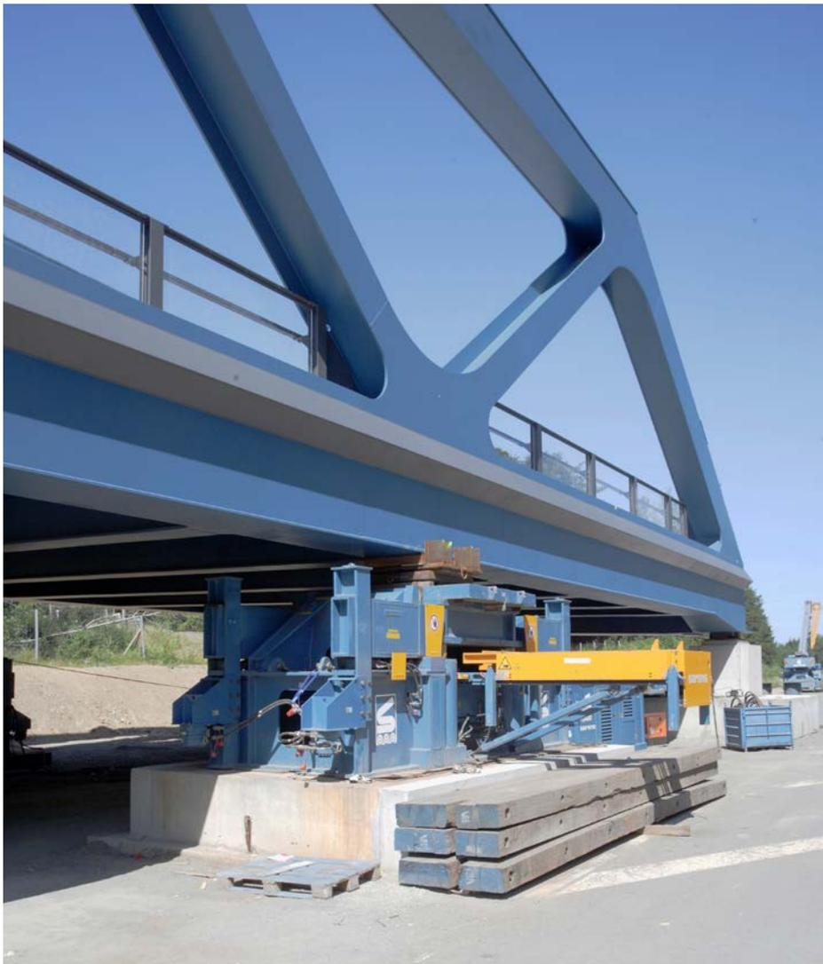
Realisierbar wurde diese Strategie durch den Einsatz von sogenannten Selbstfahrenden Plattform-Modultransportern (SPMT), mit denen die gesamte Brücke, die eine 2900 Tonnen und die andere 3200 Tonnen schwer, millimetergenau zu bewegen war. Geschehen ist dies im vergangenen Juli während der bundesdeutschen Sommerferienzeit, natürlich unter Vollsperrung der Autobahn, jedoch an nur einem Wochenende.
