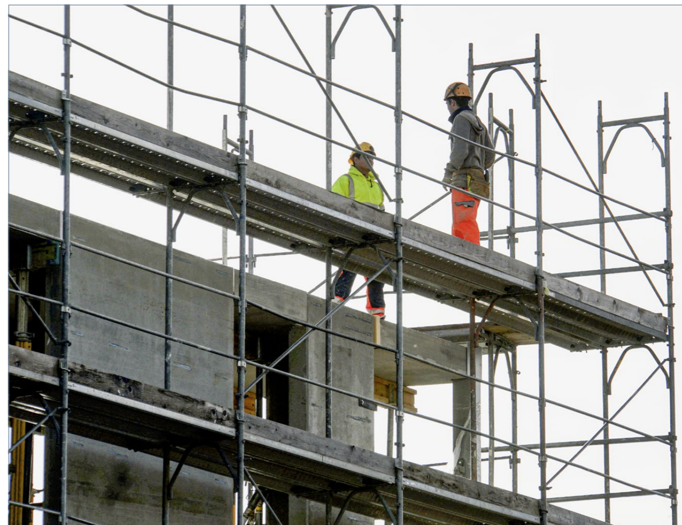
Bauarbeiter im Gegenlicht auf einer Baustelle in Zürich Nord.
