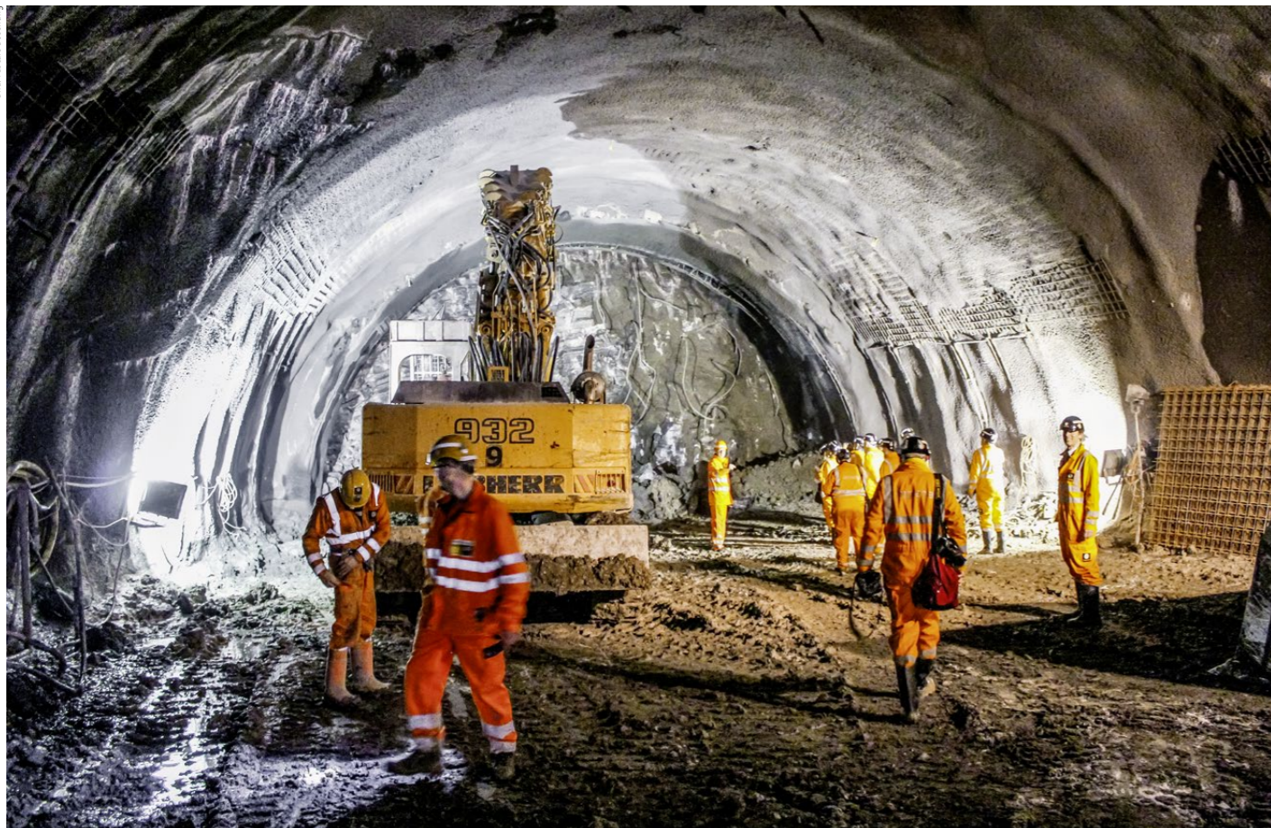
Beim Bau des Bözberg-Eisenbahntunnels haben die SBB ein neues Kooperationsmodell erprobt.
