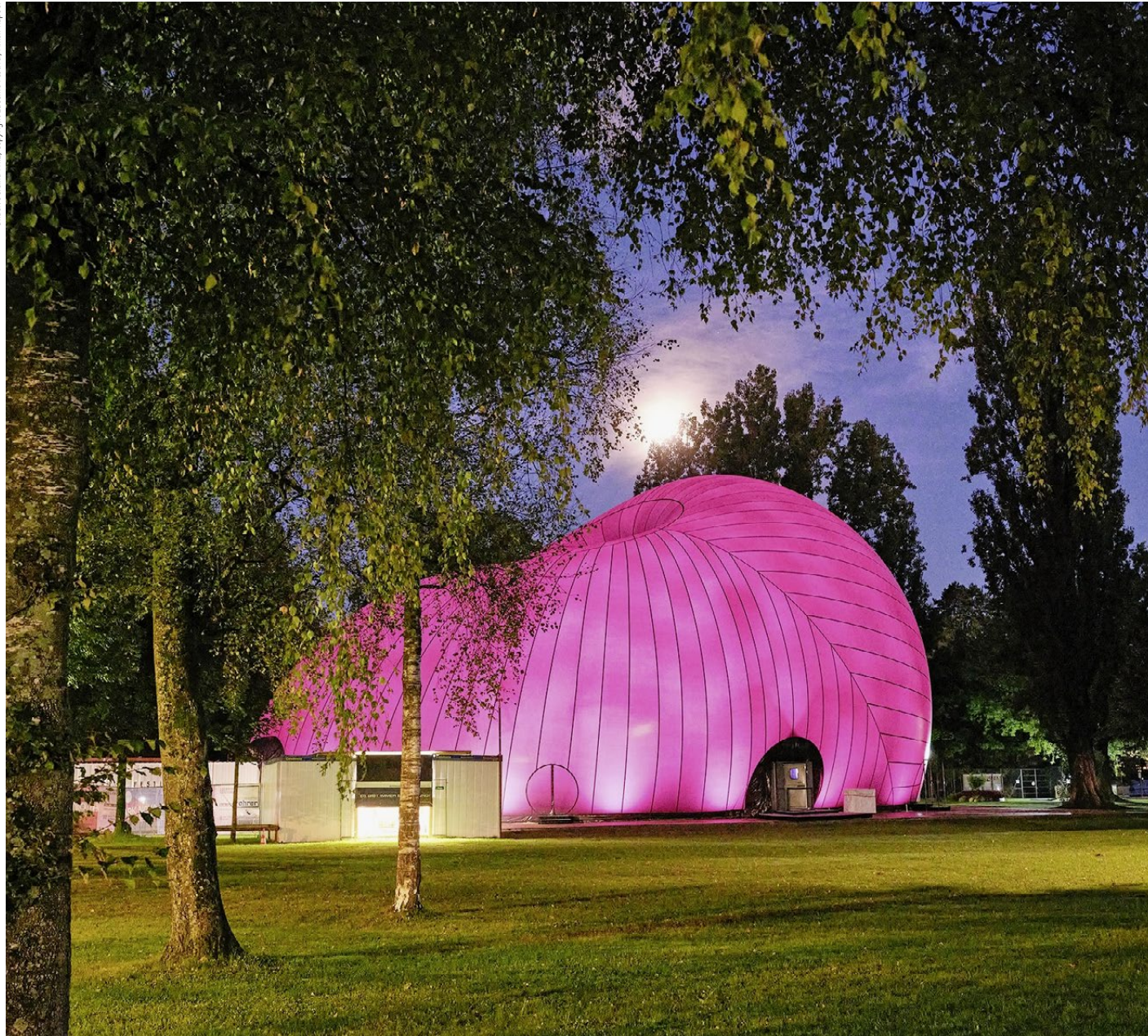
Im beleuchteten Zustand erscheint die Ark Nova pink, da die Kunststoffhaut transluzent ist. Links im Bild die Container für die drei Gebläse, die den mobilen Bau stabil halten.
