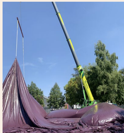
Ein Mobilkran hob die Folie sanft an, während das Zelt mit Luft gefüllt wurde. Nach rund zwei Stunden war die Ark Nova aufgeblasen.
