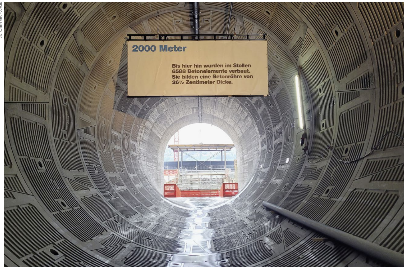
Smarte Tübbinge: Die Struktur sorgt für einen idealen Wasser-Durchfluss und bremst die Wassermassen auf ihrem Weg zum Zürichsee.
