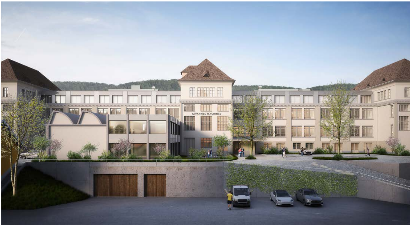
Das Fabrikgebäude liess die Uhrenmanufaktur «Tavannes Watch» 1918 erstellen. Bis 2028 wird der emblematische Bau für 75 bis 80 Millionen Franken vollständig renoviert für die künftige Nutzung als regionales Verwaltungsgebäude.
