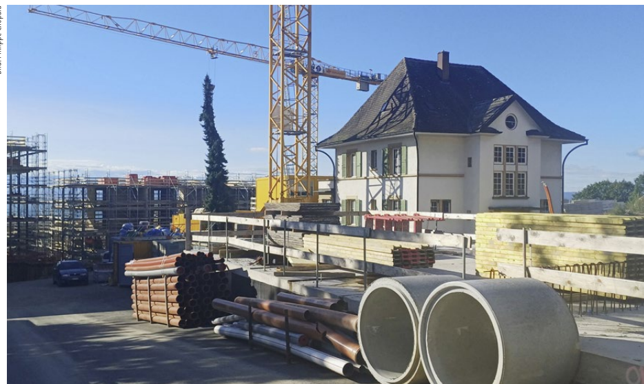
Mit dem laufenden Projekt «Concept B.180» von Bonhôte-Immobilier SICAV entstehen im Westen von Neuenburg neue Wohnungen. Der Bau geht zudem mit dem Ausbau eines Fernwärmenetzes einher.
