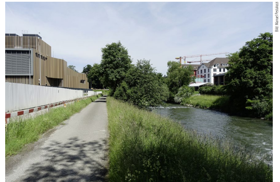
Gegenüber vom «Riverside» ist ein Datencenter entstanden. Es soll seinen Nachbarn mit Abwärme versorgen.
