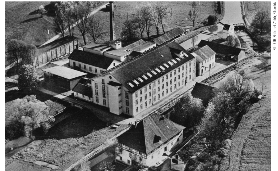
Die kompakte Gebäudegruppe der Spinnerei Jakobstal wurde zum «Lost Place» und ist nicht mehr zu retten.
