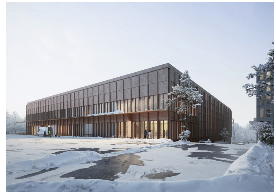
An der Nordfassade befindet sich die zweigeschossige Raumschicht, in welcher der Betrieb sichergestellt wird.
