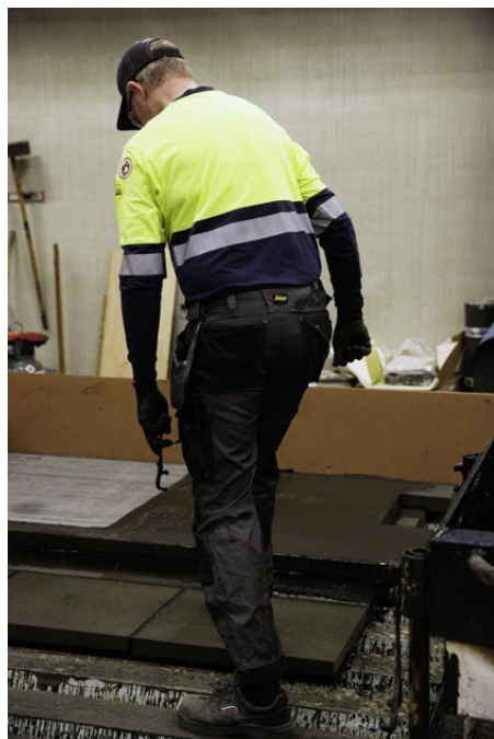
Der Monteur legt das Schaumglas auf das Trapezblech und presst es dort durch sein Auftreten fest, bis das Bitumen erstarrt ist.
