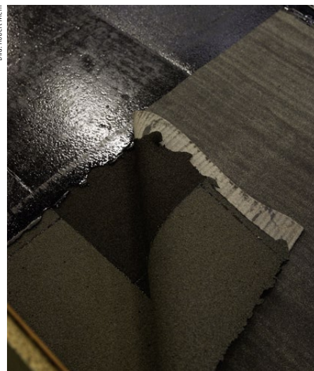
Für die Sanierung alter Foamglas-Elemente genügt es, die werkseitig aufgebrachte Schutzfolie abzureissen.
