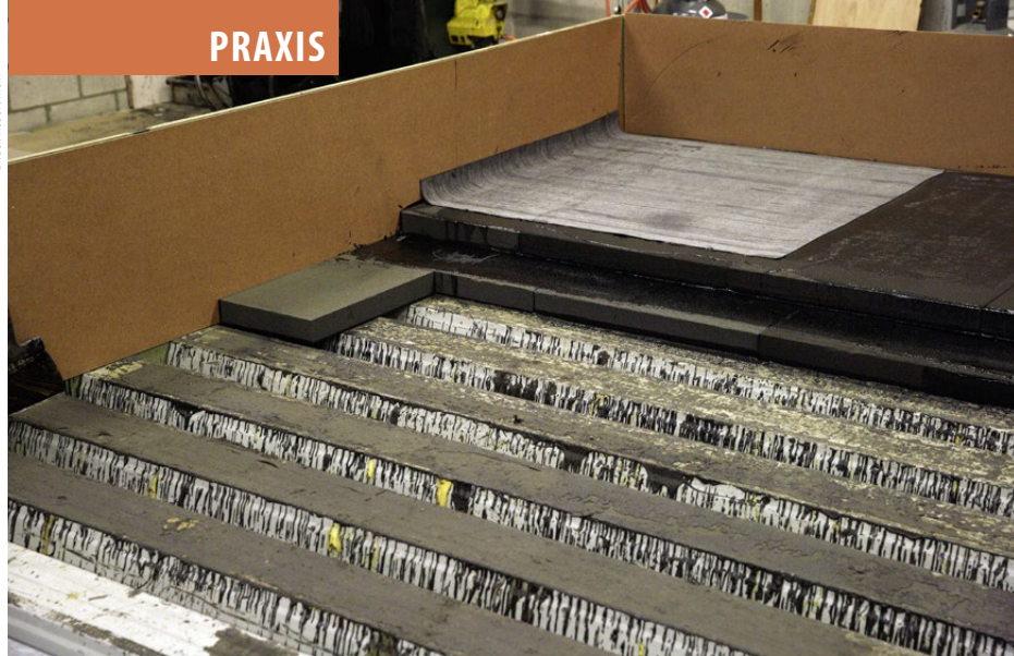
Hier wird Schaumglas in zwei Lagen auf ein Trapezblechdach montiert.
