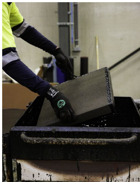
Dafür wird das Schaumglas-Paneel halbseitig in flüssiges Heissbitumen getaucht.
