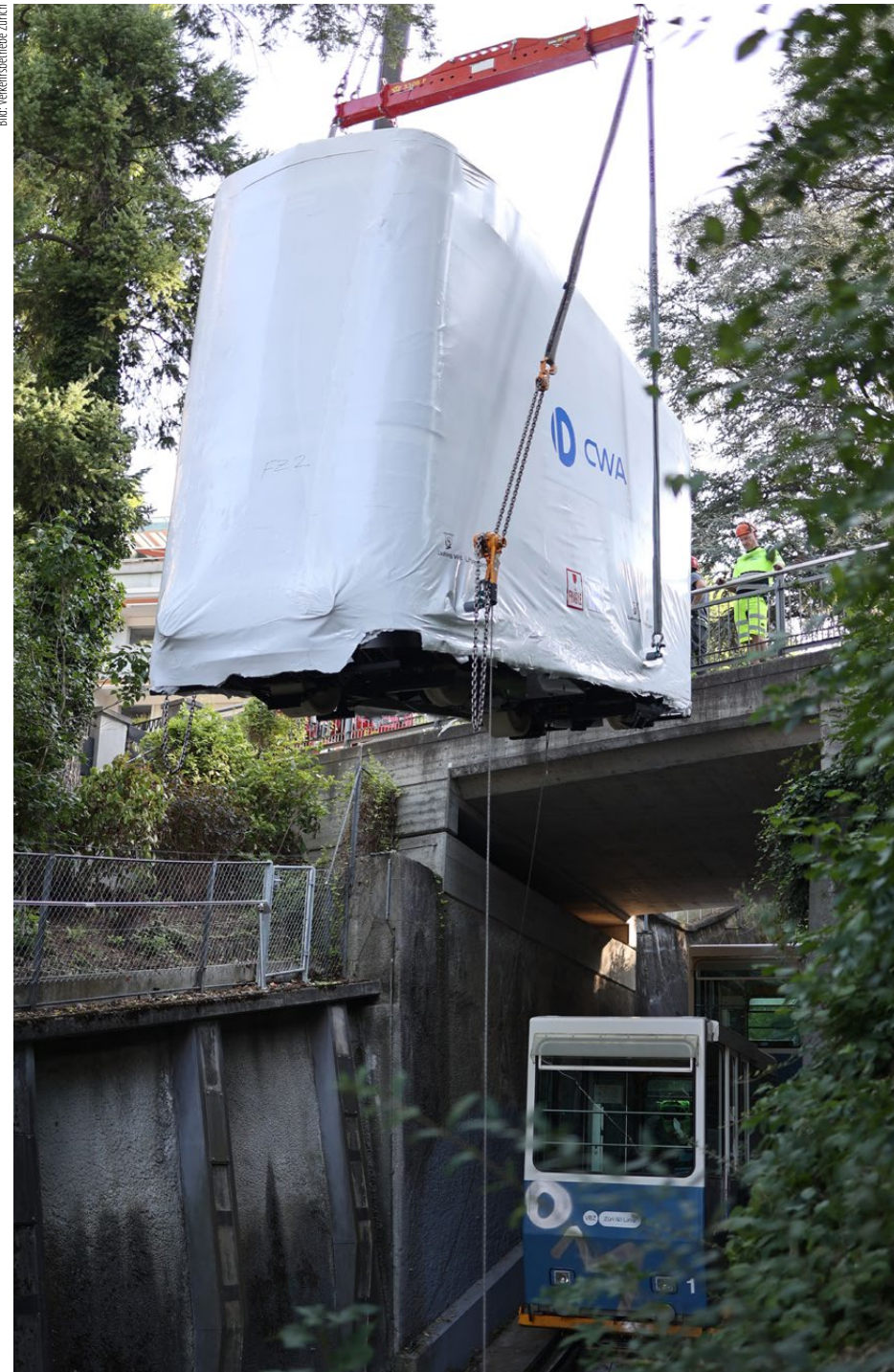
Generationenwechsel im Trasse der Seilbahn Rigiblick in der Stadt Zürich: Die alte Standseilbahn-Kabine wartet auf ihren Abtransport, während die neue per Kran an ihren Einsatzort gelangt.
