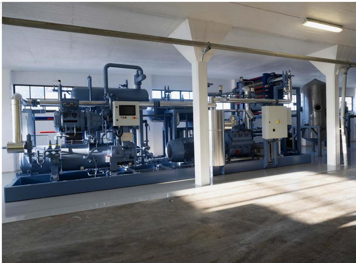
Seit 2024 ist in Trondheim (Norwegen) eine Ammoniak-Wärmepumpe in Betrieb, die in einem Werk für Tierfutter 120-gradigen Dampf mit einer Leistung von 1,6MW bereitstellt.
