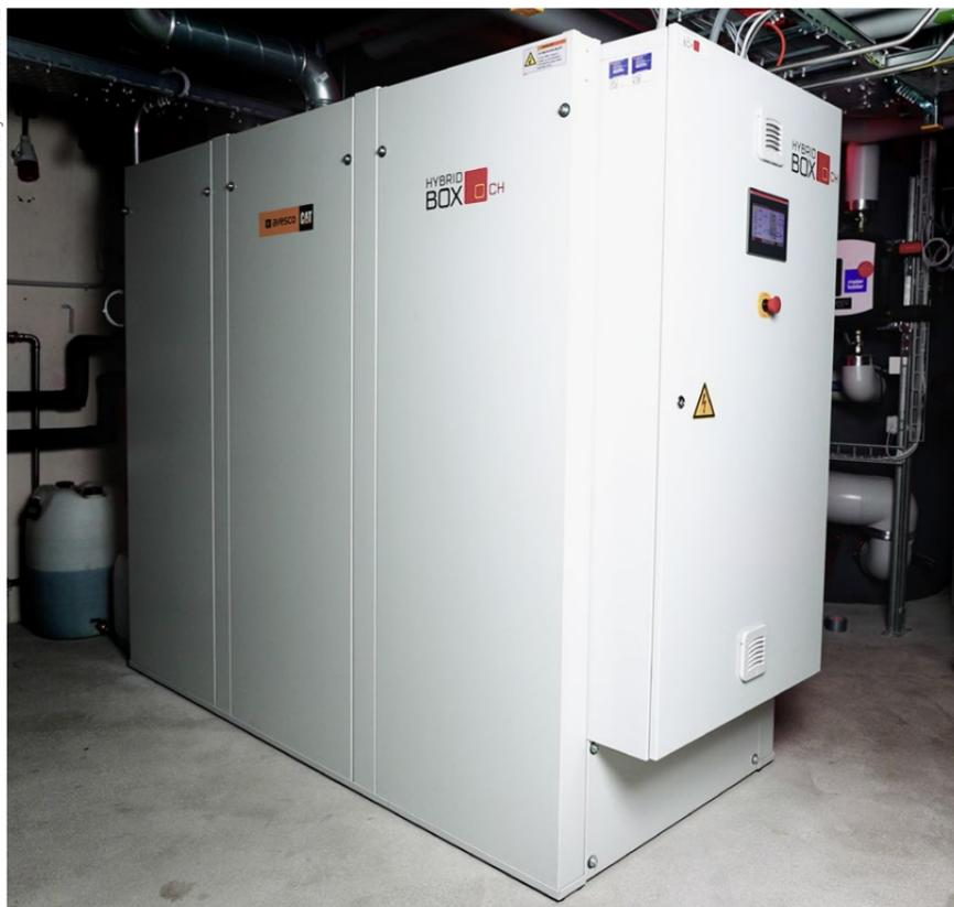
Zentraler Baustein der Energieversorgung: Im Heizungskeller steht eine Hybridbox, die für den Betrieb mit Methanol umgerüstet wurde.
