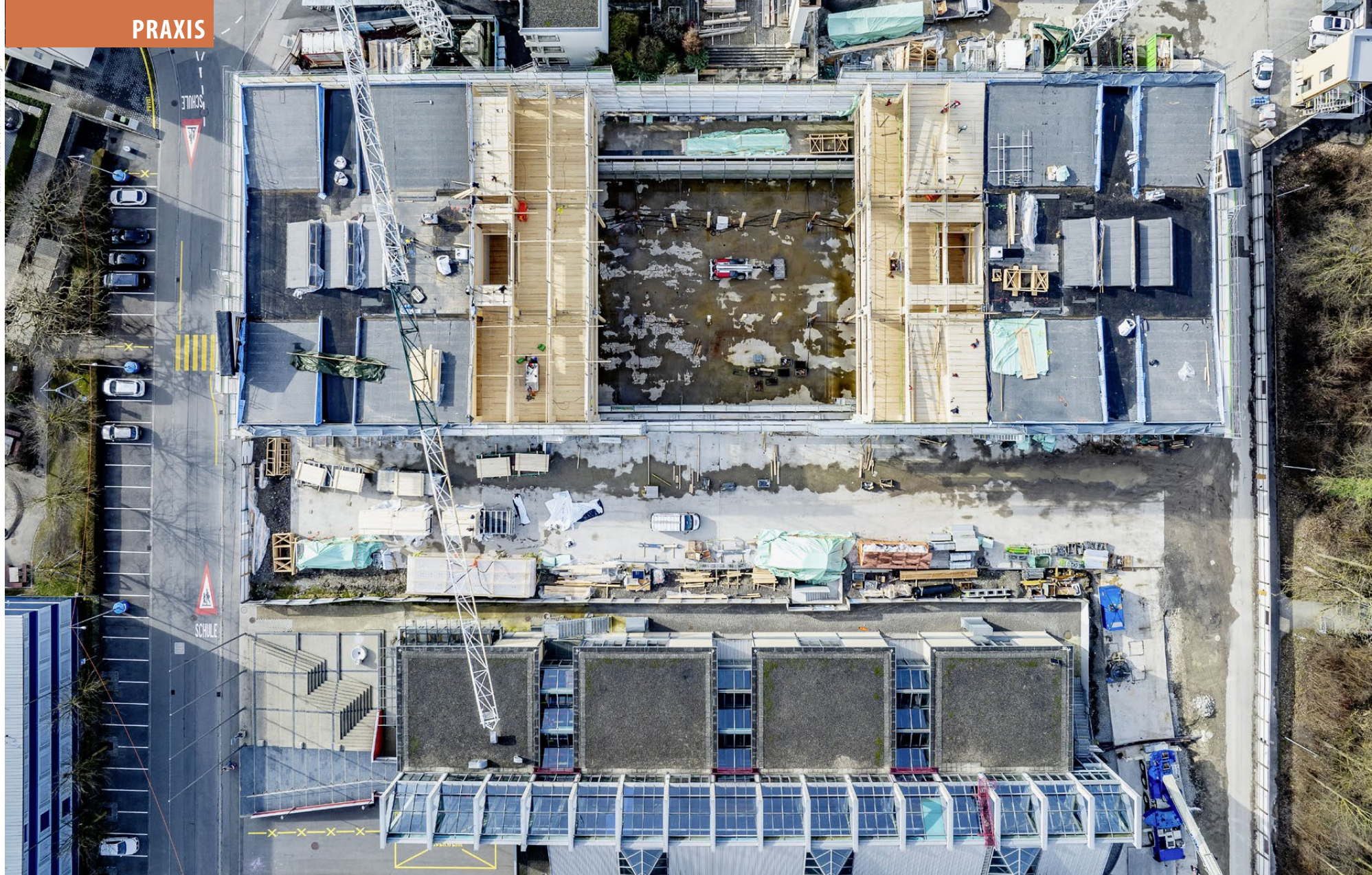
Die Baustelle der Schule Wiesental in Baar ZG, im Frühling 2024.
