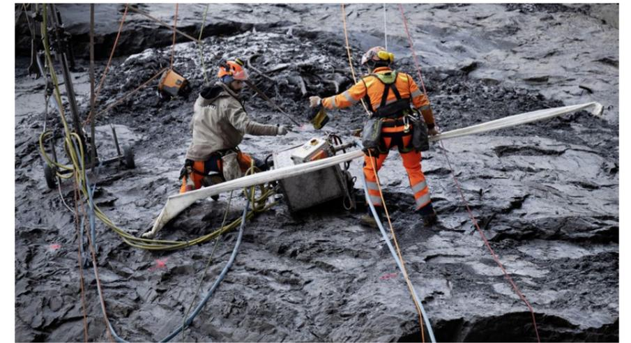
Der Boden des Stausees war mit einer dicken Schicht aus Schlamm bedeckt, der für die Arbeiter äusserst beschwerliche Bedingungen schuf. Derselbe Schlamm hatte auch den Grundablass teilweise blockiert.
