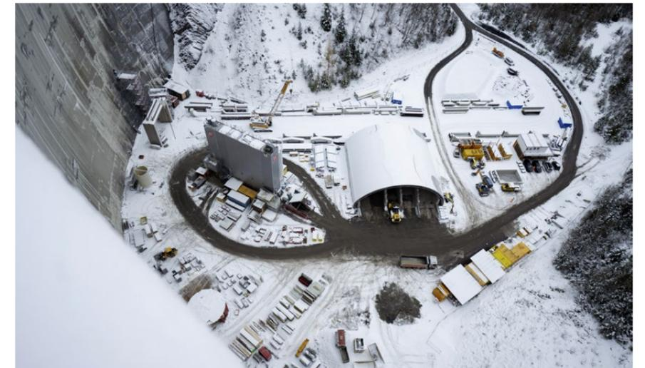
Der Installationsplatz am Fusse der Staumauer, mitsamt Betonwerk: Die fertig eingerichtete Baustelle konnte erst nach zwei Jahren Verzögerung ihre Arbeit aufnehmen.
