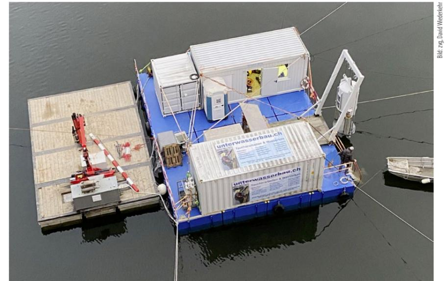
Ein Hilfsfloss in offenem Wasser, zusammengesetzt aus Elementen, die die Bautaucher selbst mitbringen. Von da aus sind sie näher am Einsatzort und können auf dem Floss bei Bedarf zusätzlich Baumaschinen platzieren.
