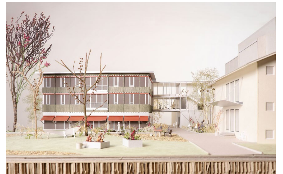
Der freistehende Erweiterungsbau ist über eine zweigeschossige Brücke mit dem bestehenden Primarschulhaus verbunden.
