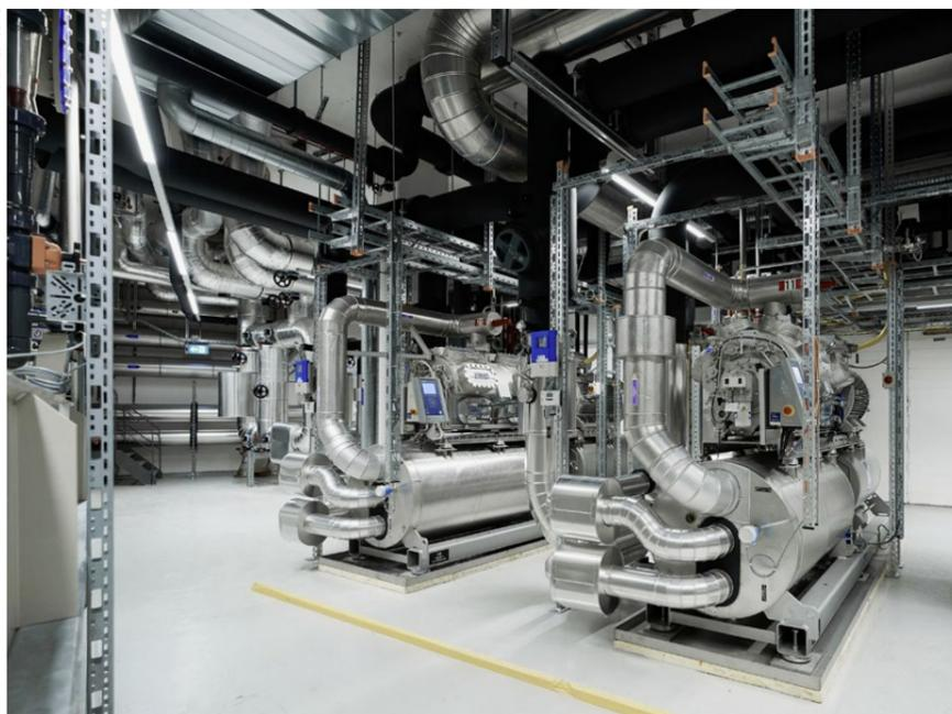
Wärmepumpen in der bestehenden See-Energiezentrale Inseliquai in Luzern. Die Stadt und ihr Energie- und Wasserwerk EWL planen den Bau vier weiterer solcher Zentralen und einen grossflächigen Ausbau des Fernwärmenetzes.
