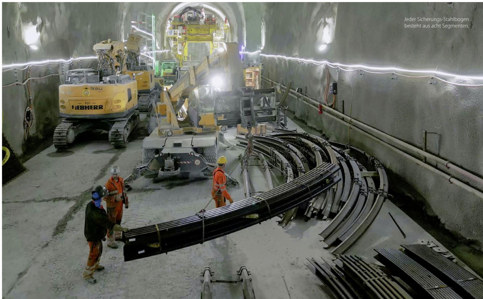
Jeder Sicherungs-Stahlbogen besteht aus acht Segmenten.
