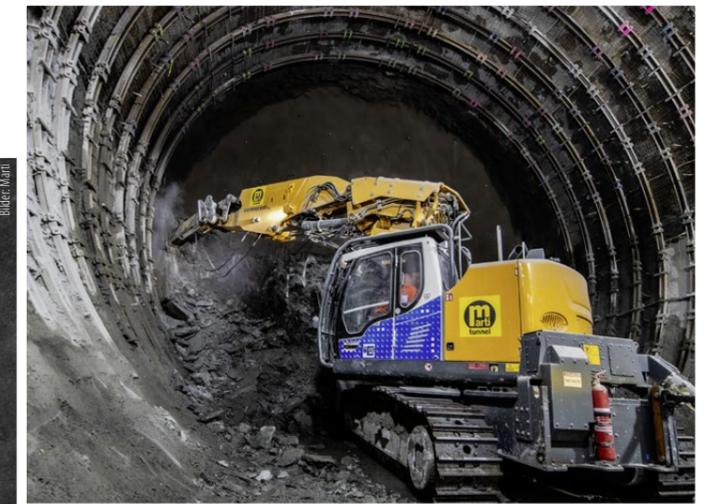
Erstmals setzt Marti auf einer Baustelle auf Elektro-Tunnelbagger: Für den Ausbruch auf der unteren Arbeitsebene kommt ein Liebherr 950 zum Einsatz.
