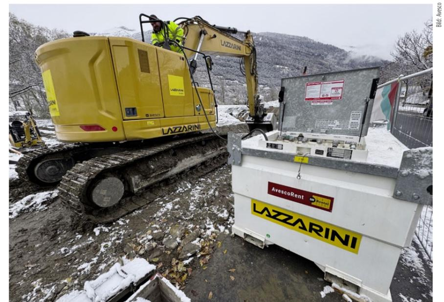
Der Raupenbagger wird betankt: Mit HVO entsteht bei der Verbrennung kaum Russ, was den Motor langfristig schont.
