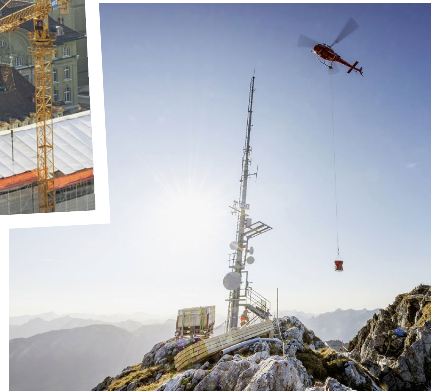
Bisweilen gehts ganz hoch hinaus: Ein Unterlast-Helikopter bringt Material auf eine Gebirgsbaustelle.
