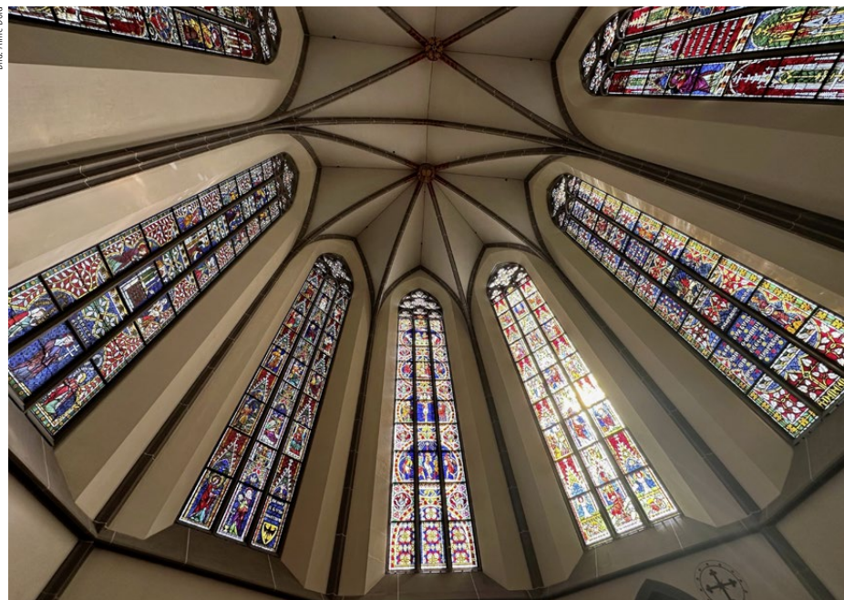
Der Fensterzyklus mit Glasmalereien in der Klosterkirche Königsfelden im Kanton Aargau: Über zwei Jahre lang waren Aline Dold und ihr Team mit den Restaurierungsarbeiten an den 330 Glasfeldern beschäftigt.
