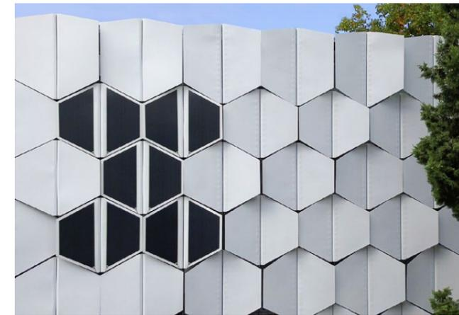
Ansicht der Fassade bei vollständig geschlossenen Modulen.
