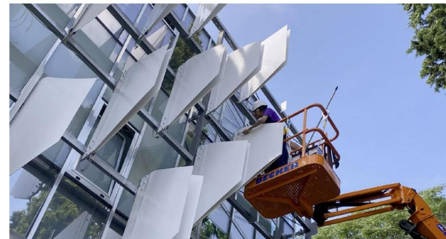
Die Installation der Module an der Gebäudefassade, der ein spezieller Stahlrahmen für die Anbringung vorgelegt ist.
