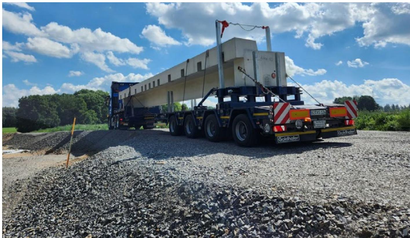
Im Herstellerwerk vorgefertigte carbonbewehrte Träger gelangten per Tieflader zur Baustelle, wo sie durch Quervorspannung zusammengefügt wurden, sodass Brücken rasch einsatzbereit sind.
