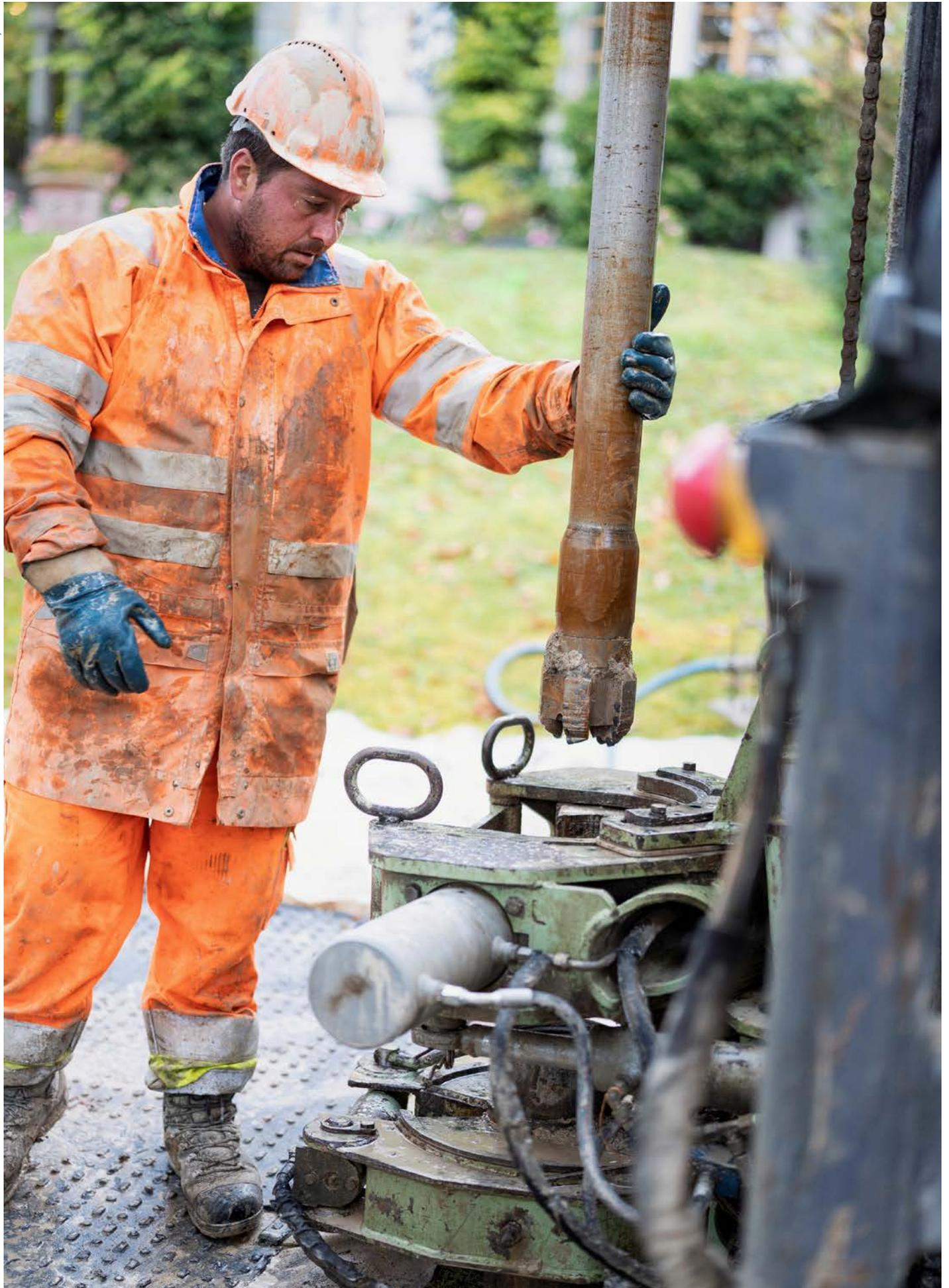
Bohrlöcher für Erdwärmesonden im Niedertemperaturbereich reichen bis in eine Tiefe von 400 Metern, wobei der Fokus der Potenzialanalyse auf der Nutzung des Erdreichs liegt.
