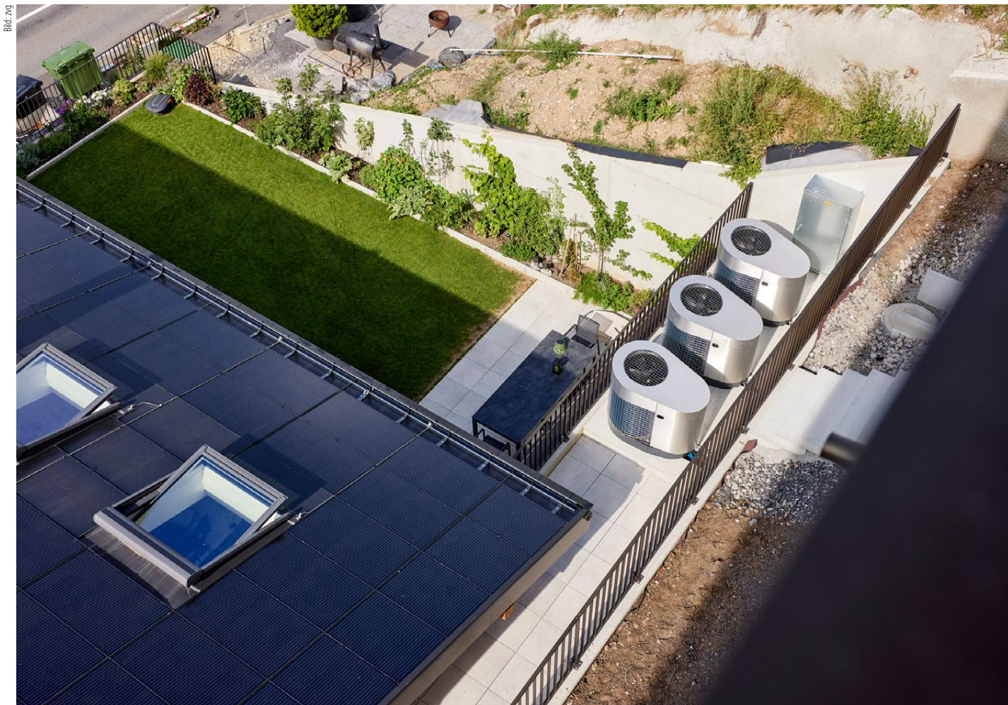
Rundum erneuerbar: Ein Neubau in Merligen BE besitzt vollflächige Solardächer. Diese speisen auch drei Luft-Wasser-Wärmepumpen.
