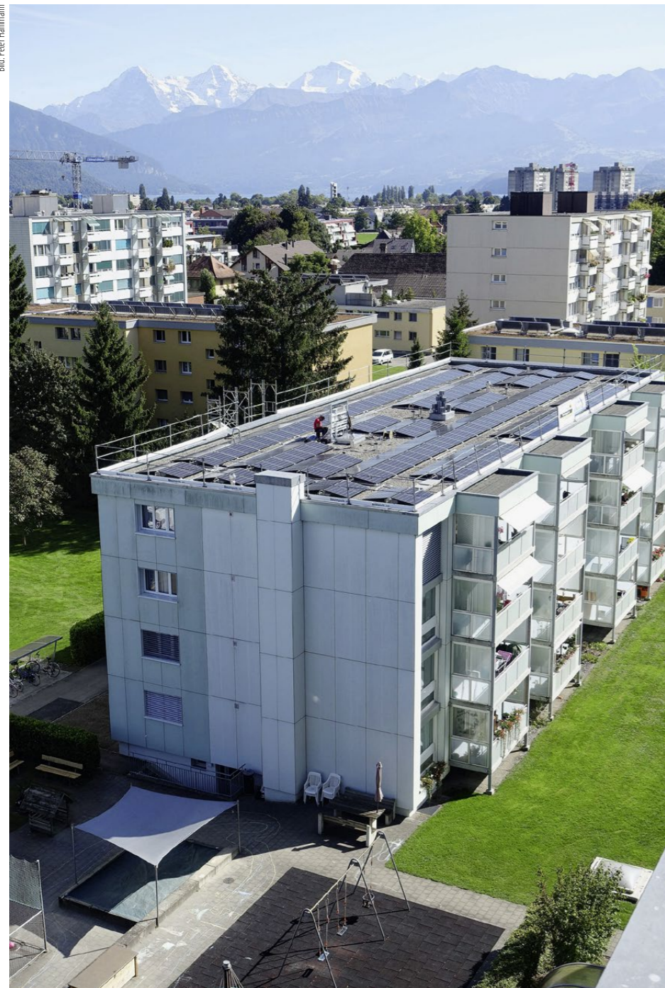
Allein die Anlage auf den Häusern 103 und 105 bringt eine Leistung von über 60 kWp. Die PV-Leistung aller sanierten Gebäude (ohne Neubau) beläuft sich auf 330 kWp.
