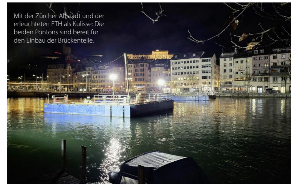
Zuerst werden auf die Pontons die beiden Gondeln gehoben; erst danach folgen die langen Verbindungsteile der Brücke.
