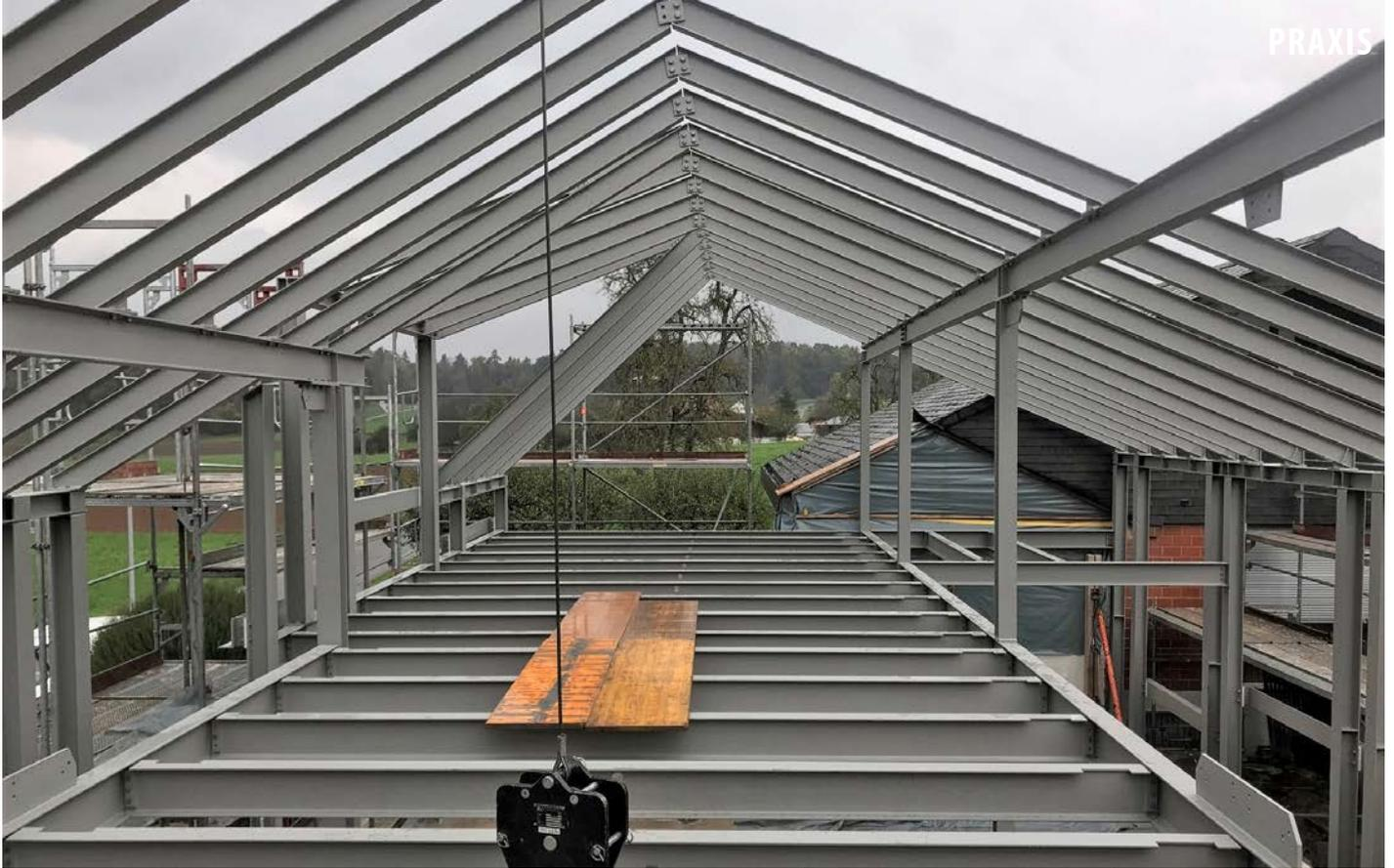
Stahl statt Holz. Das Fachwerk besteht aus einer Stahlkonstruktion.
