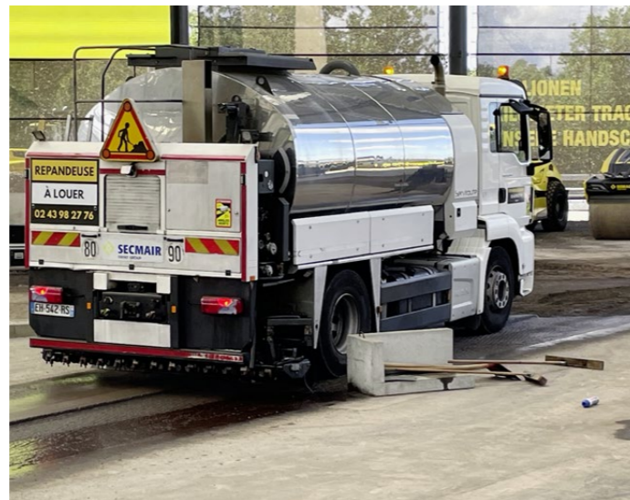
Noch einmal ist Fayat beim Strassenbau im Spiel: Mit dem Fahrzeug von Secmair gelingt auch das Anspritzen der ausgefrästen Strassenpartie mit Bitumenemulsion.
