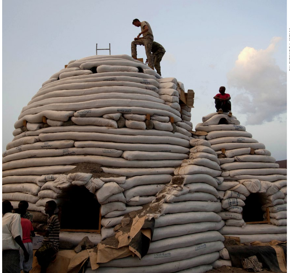
Die bienenstockförmigen «Super Adobe»-Strukturen verwenden Kragbögen, -kuppeln und -gewölbe. Im Bild: Einwohner bauen im abgelegenen Dorf Karatbi San in Dschibuti ein Haus.
