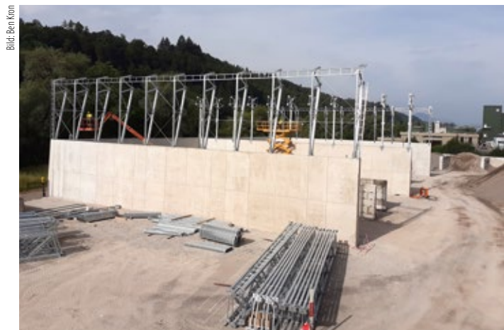
Die neue Halle der JMS Gruppe in Schmerikon SG: Noch fehlt das Dach auf den Betonmauern, für die erstmals der neue, klinkerreduzierte Zement zum Einsatz kam.
