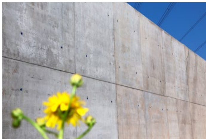
Auch farblich hebt sich der neue Zement durch seine erdig-warme Farbe vom herkömmlichen Grau von Betonwänden ab.
