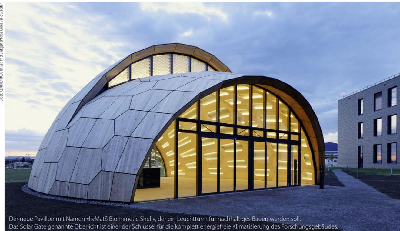
Der neue Pavillon mit Namen «livMatS Biomimetic Shell», der ein Leuchtturm für nachhaltiges Bauen werden soll. Das Solar Gate genannte Oberlicht ist einer der Schlüssel für die komplett energiefreie Klimatisierung des Forschungsgebäudes.
