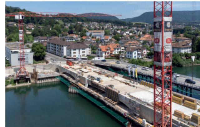
Der Rohbau der Aarebrücke neben der Hilfsbrücke, welche während der Bauzeit täglich über 20 000 Fahrzeuge bewältigte.
