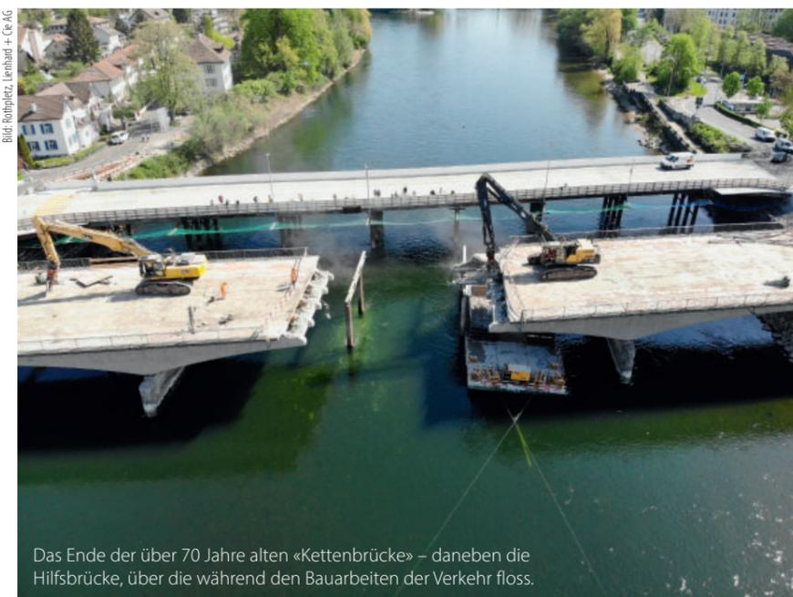
Das Ende der über 70 Jahre alten «Kettenbrücke» – daneben die Hilfsbrücke, über die während den Bauarbeiten der Verkehr floss.
