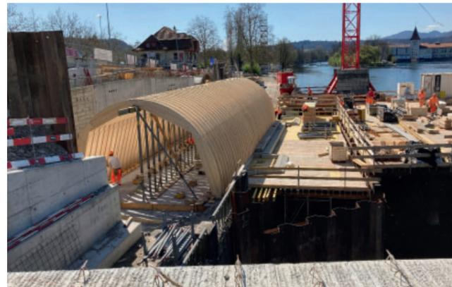
Die Gewölbeschalung für die Uferpromenade steht bereit: Der Durchgang wurde auf sechs Meter erhöht und ist nun auch zu Pferd passierbar.
