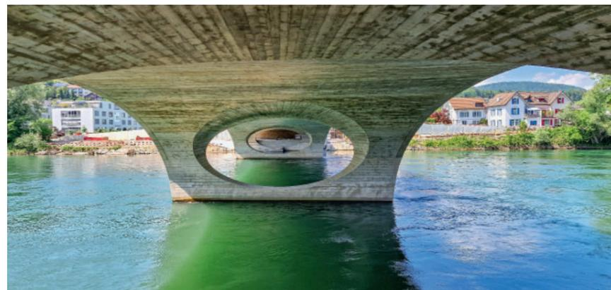
Die Unteransicht der neuen Brückenbögen, deren komplexe Geometrie für die Schalung und den Guss eine Herausforderung darstellte.
