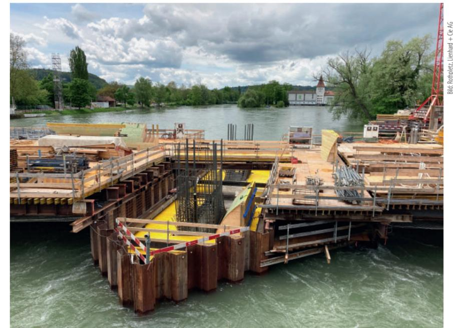
Eine Pfeilerbaugrube der neuen Aarebrücke: Das Bauen mitten in der Aare bietet eine Reihe von Herausforderungen für die Ausführenden.
