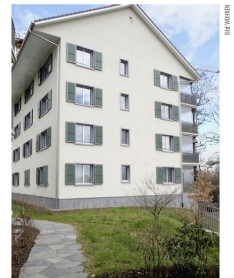
Blick auf eines der Häuser am Eidgenossenweg. Die alten Granitplatten wurden für die Gehwege neu zugeschnitten und wiederverwendet.
