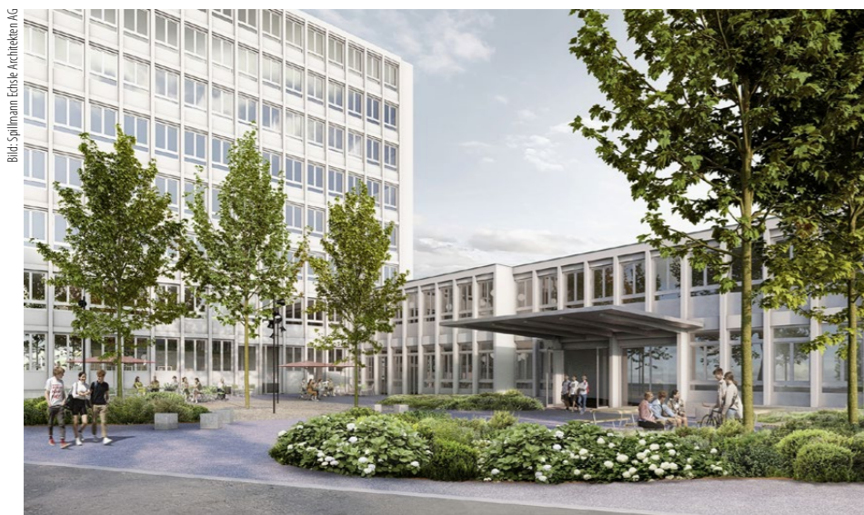
Für Schulhäuser sind hohe Investitionen geplant. Die Gebäude auf dem Brunnenhof-Areal in Zürich, wo sich früher das Radiostudio befand, werden zur Deckung des Schulraumbedarfs umgebaut.
