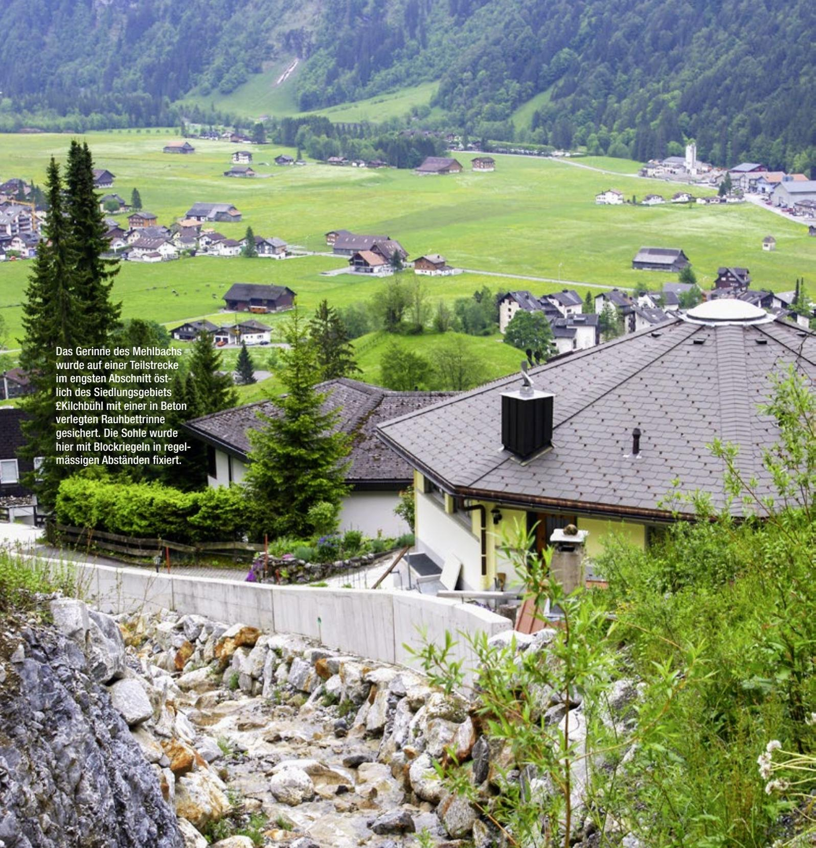
Das Gerinne des Mehlbachs wurde auf einer Teilstrecke im engsten Abschnitt östlich des Siedlungsgebiets Kilchbühl mit einer in Beton verlegten Rohbettrinne gesichert. Die Sohle wurde hier mit Blockriegeln in regelmässigen Abständen fixiert.
