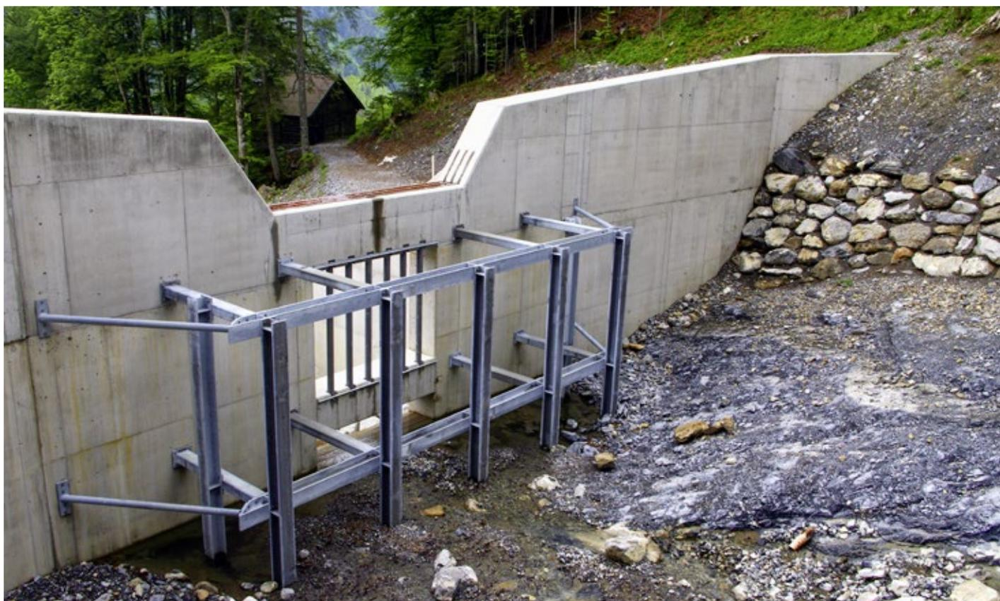
Der Geschiebesammler ist als Pfeilerplattensperre ausgeführt. Diese Bauweise ist für grosse Talbreiten geeignet.
