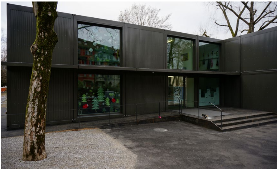
Kindergarten-Neubau in Biel: Auch hier setzt man auf Container, da diese bei sinkendem Raumbedarf einfacher umgenutzt werden können.
