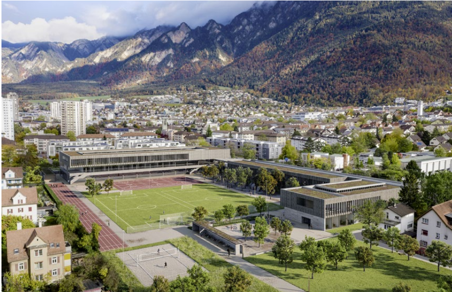
Projekt «Fortuna» beim Schulhaus Ringstrasse in Chur: Der Neubau, der 89 Millionen Franken kostet, wurde 2021 vom Stimmvolk gutgeheissen.
