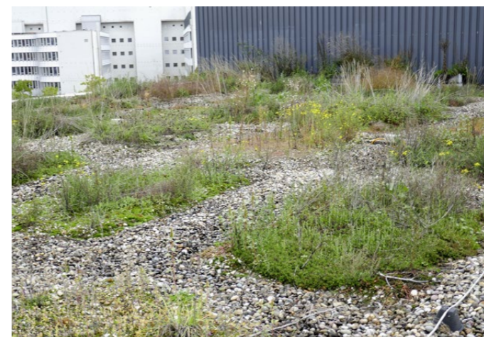
Versuchsfläche auf dem Dach des Schweizer Fernsehens in Zürich, die von der ZHAW-Forschungsgruppe betreut wird. Hier wird getestet, wie sich Wolle oder Stroh als Unterbau mit verschiedenen Substraten bewähren.
