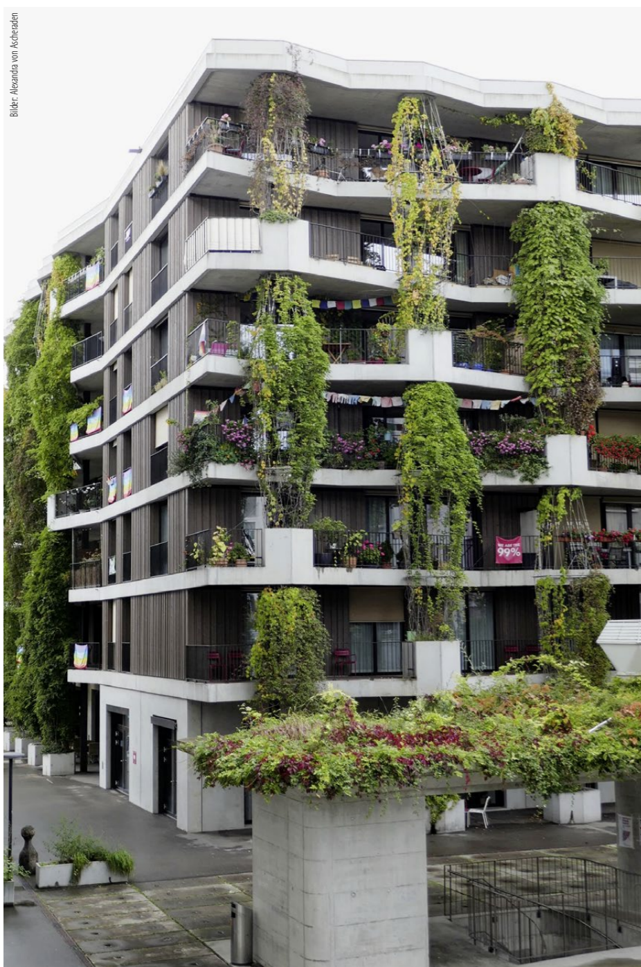
Das Hunziker Areal in Zürich ist durch viel Grün attraktiv. Die Fassadenbegrünung wächst in grossen Pflanztöpfen und wird automatisch bewässert.
