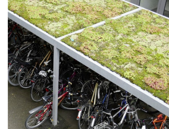
Begrüntes Dach eines Veloabstellplatzes im Hunziker Areal. Optisch attraktiv, leider wurden hier aber vor allem nicht-heimische Sedumarten verwendet.
