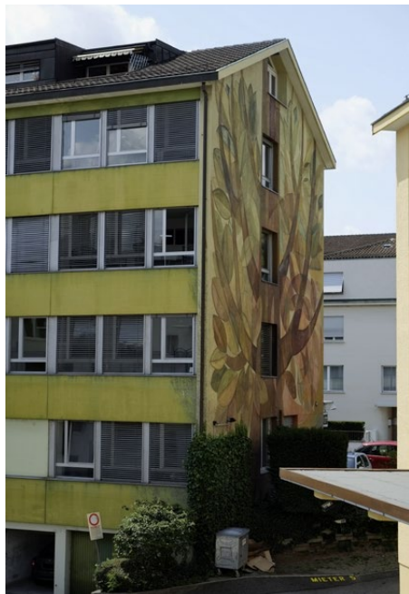
In den Jalousie-Kästen dieses Hauses nisteten alljährlich zahlreiche Spatzen. Die Kästen wurden im Zuge der Fassadenrenovierung jedoch entfernt.
