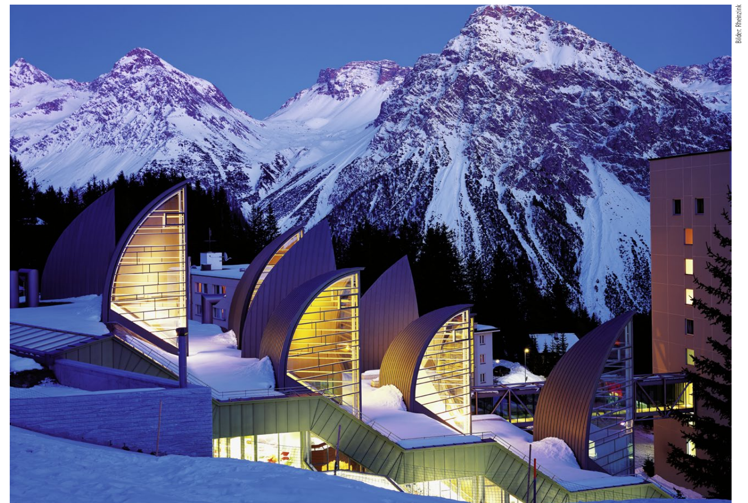
Das von Mario Botta entworfene Tschuggen Grand Hotel in Arosa, dessen neun «Lichtsegel» auf der Rückseite mit schiefergrauen Titanzinkblechen bedacht sind.
