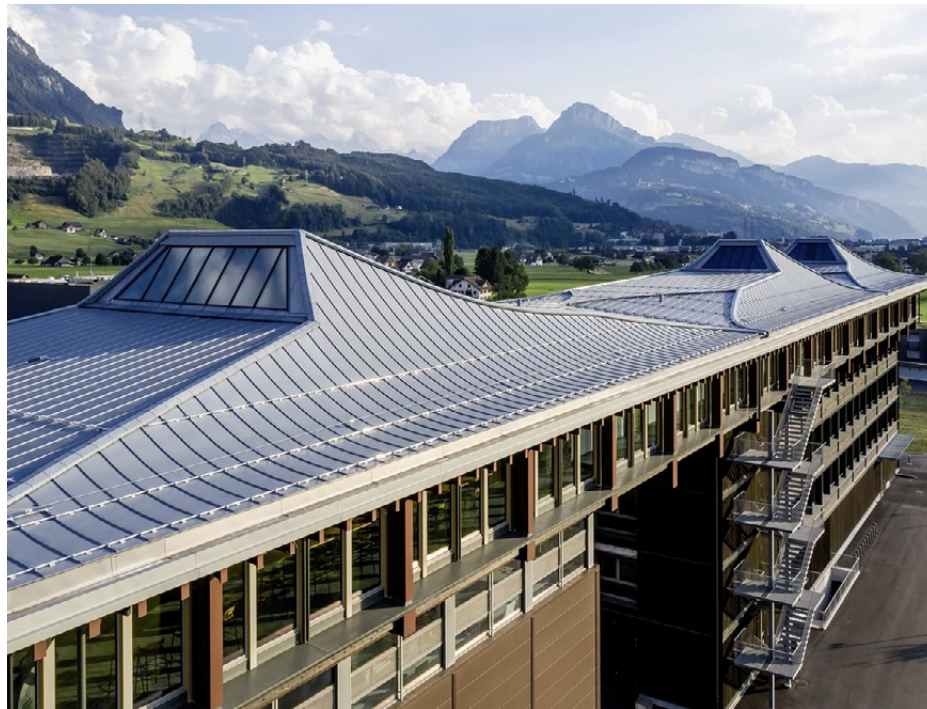
Das Dach des Firmensitzes des Schokoladenherstellers Max Felchlin AG in Ibach ist mit bläulich-grauem Titanzink eingedeckt.
