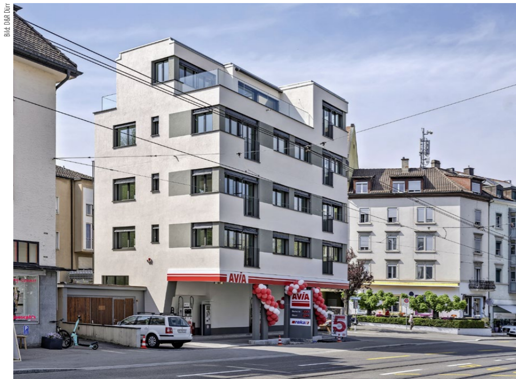
Drei neue Wohnungen entstanden mit einer Holz-Aufstockung auf diesem Haus in Zürich-Wollishofen.
