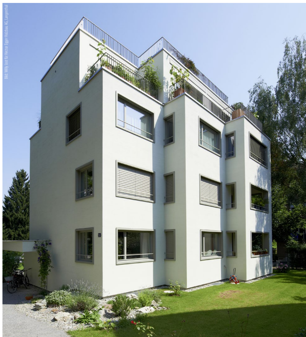
Aufstockung in Zürich-Wollishofen mit zweigeschossiger Attikawohnung.
