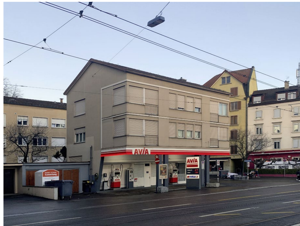
So sah das Haus in Zürich-Wollishofen vor der Sanierung und Aufstockung aus.
