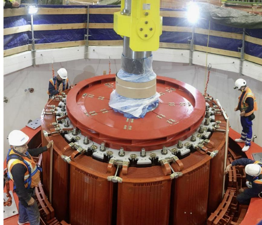
Präzisionsarbeit ist beim Einheben der Rotoren notwendig, was im Sommer des Jahres 2017 vonstatten ging.
