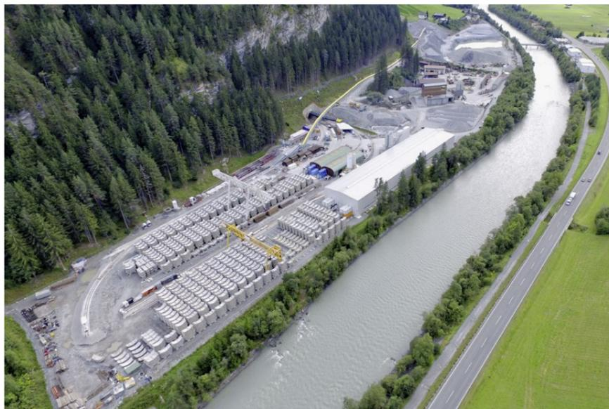
Die Tübbingfabrik und das Lager der fertigen Tübbinge: Mit diesen wurde später der 23 Kilometer lange Stollen ausgekleidet.
