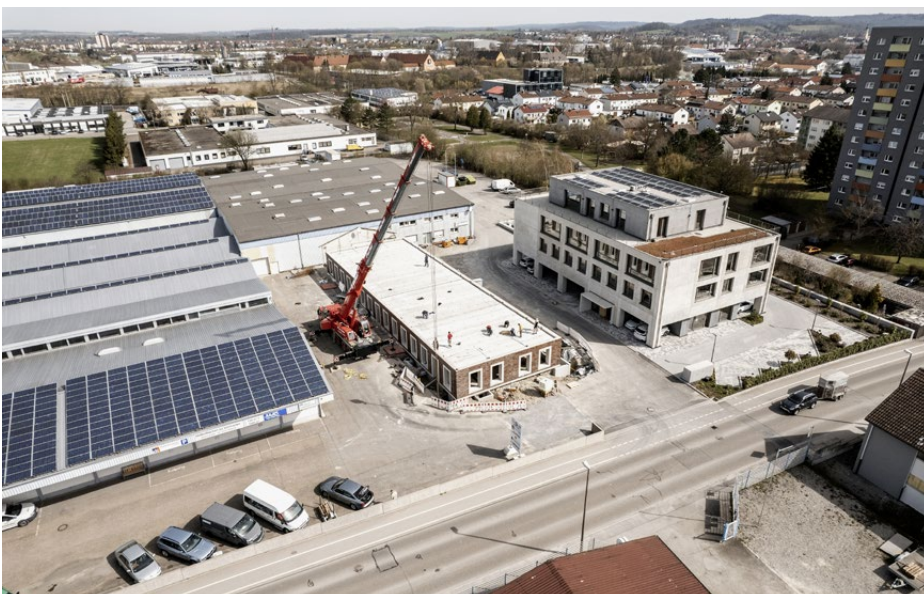
Innerhalb von drei Tagen war die Rohbaumontage abgeschlossen.
