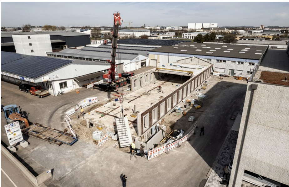
Die Spannbetonhohldecken werden auf den Fertigteilen abgelegt.
