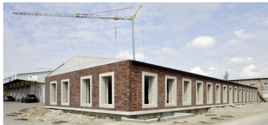
Der eingeschossige Neubau wird auf dem Firmengelände der Zuber Beton GmbH errichtet.
