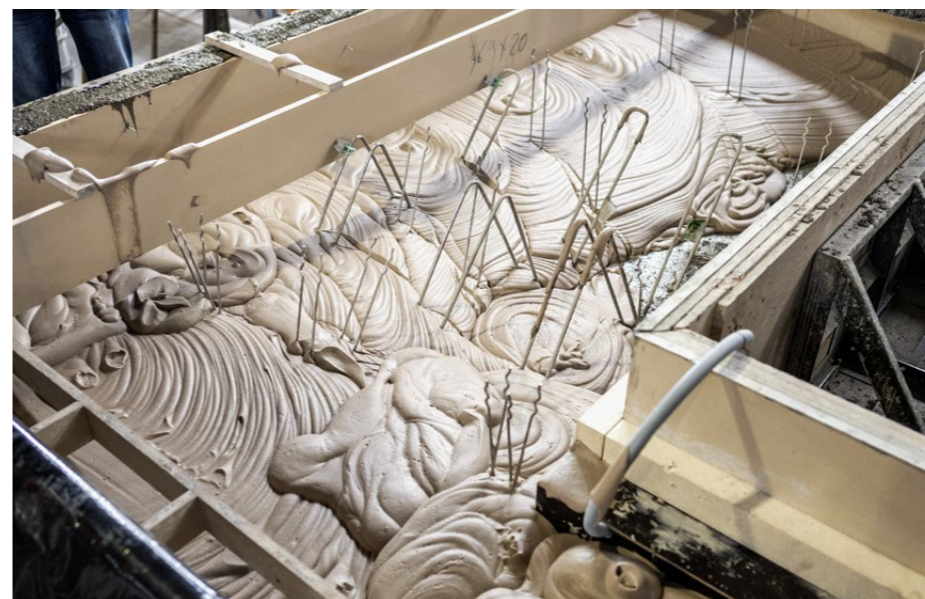
Im flüssigen Zustand hat der zementgebundene Dämmstoff eine fluffig-sahnige Konsistenz und muss nicht verdichtet werden.
