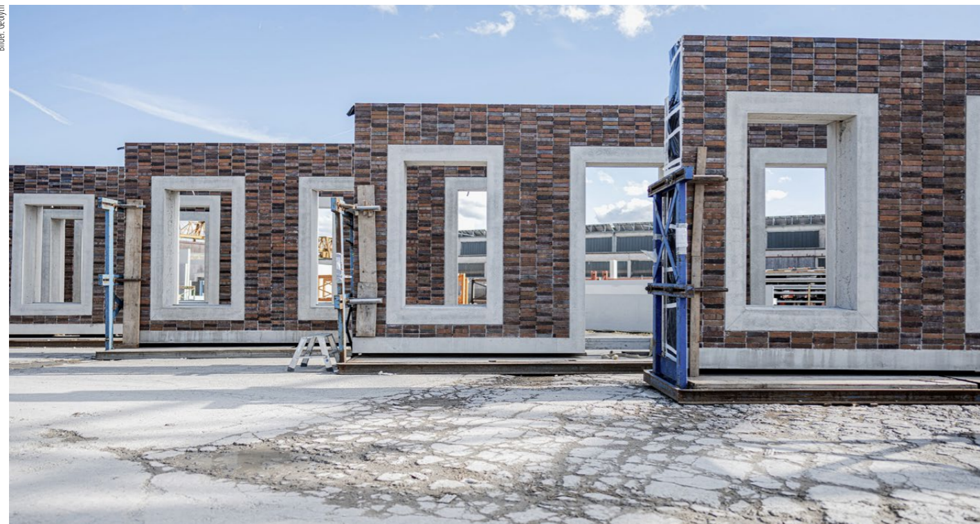
Für einen Neubau in Crailsheim wurden Aussenwände verwendet, die eine zementbasierte Mineralschaumdämmung aufweisen.
