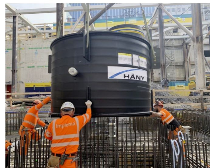
Langsam wird das grosse Schachtelement eingehoben. Drei Mitarbeiter schieben das Bauteil in die exakte Position.
