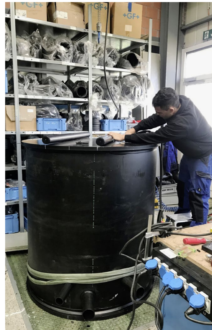
Die Schweißstellen müssen von der Oxidschicht befreit werden.
