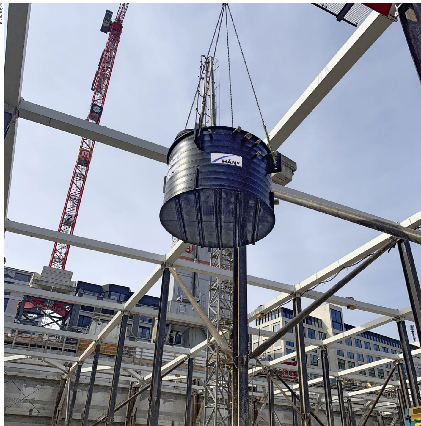
Zum Einheben des rund 1000 Kilogramm schweren Schachts kommt ein Turmdrehkran zum Einsatz.
