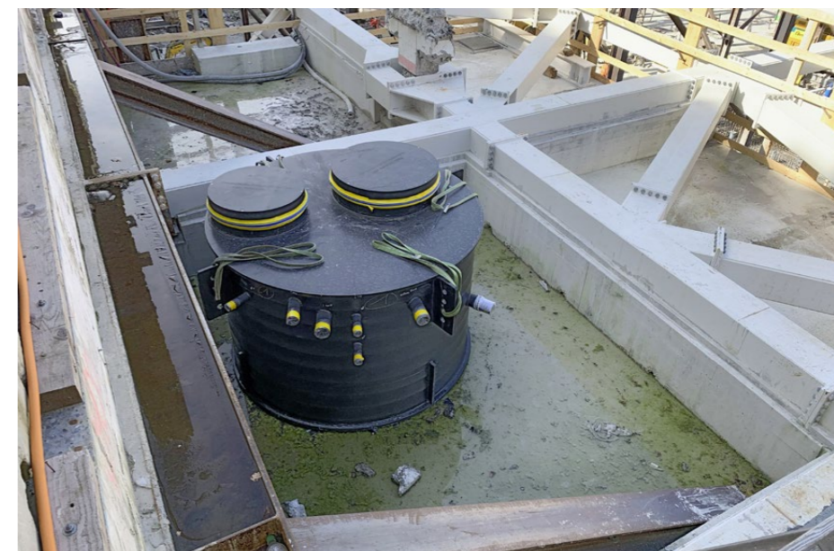
Der fixfertige Schacht wartet in der Baugrube auf die Versetzung an den vorgesehenen Standort.
