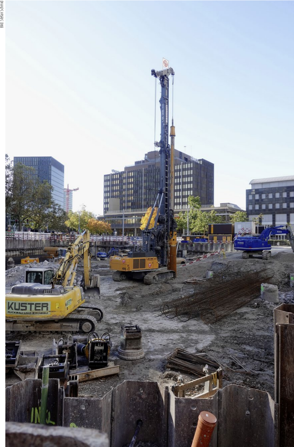
Beim Projekt Wolkenwerk haben in Zürich-Oerlikon die Bauarbeiten für den Messeturm begonnen (Bild). Er umfasst ausschliesslich Gewerbe- und Büroflächen. Die vier Türme der Überbauung bieten für 1800 Menschen Wohn- und Arbeitsräume.
