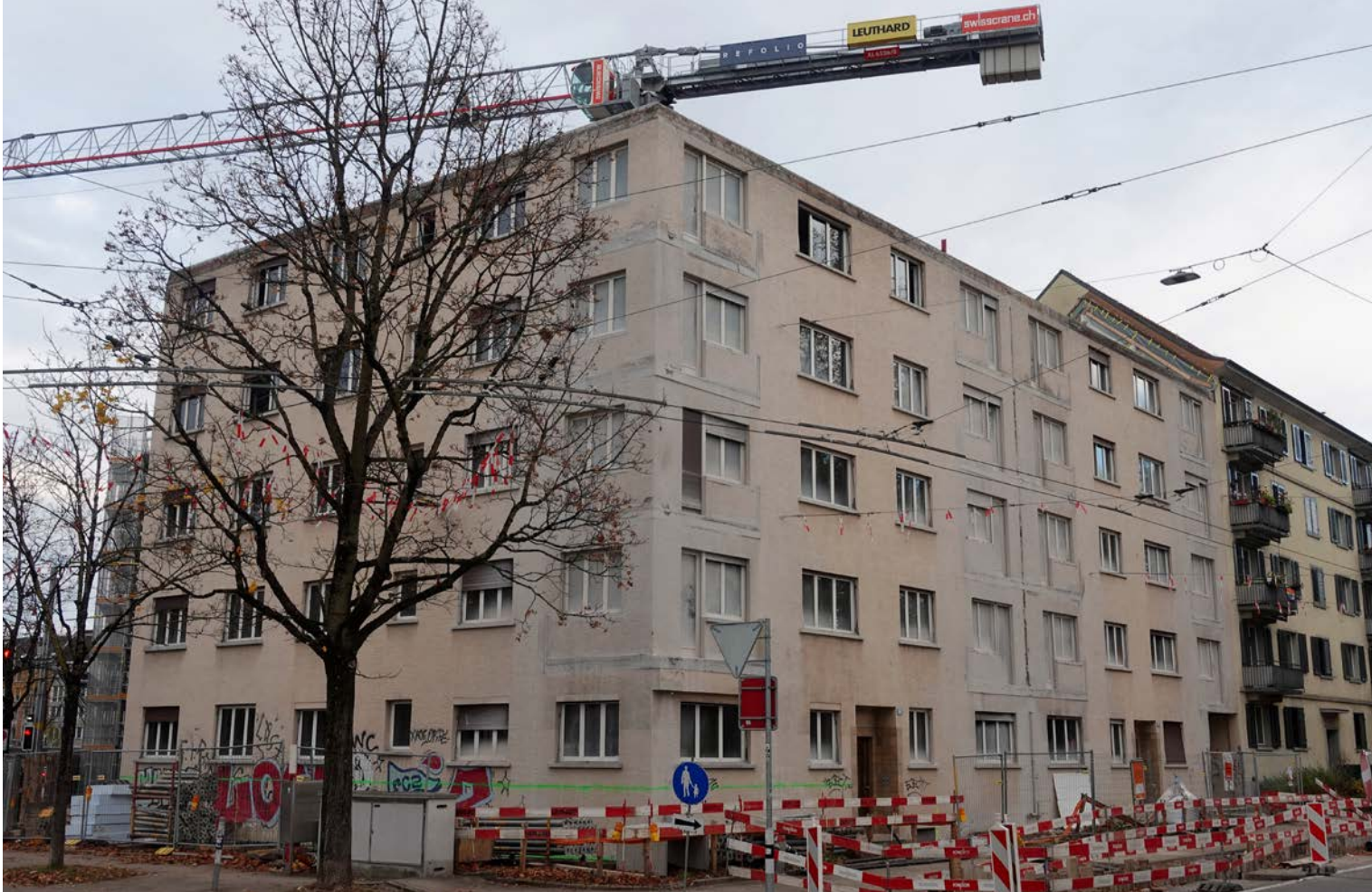
Das Segment Mehrfamilienhäuser kann die geplante Bausumme erneut markant ausweiten. Bild: Gebäudesanierung beim Albisriederplatz in Zürich.
