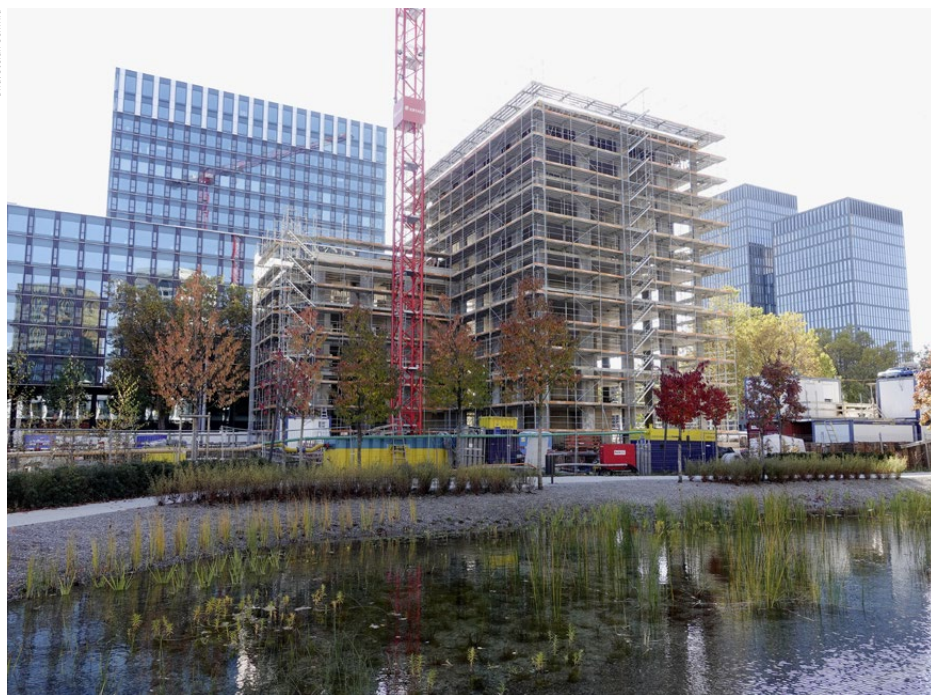
Das Segment Mehrfamilienhäuser konnte die geplante Bausumme stark ausweiten. Bild: Das Wohnhochhaus der Artisa Real Estate AG in Zürich-Oerlikon wird 80 Meter hoch.
