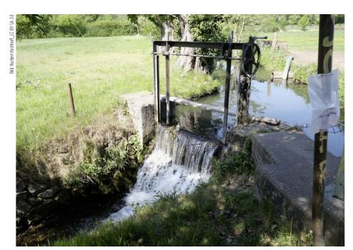
Die Technik wurde bereits von den Vorfahren eingesetzt. Mechanische Wehre regulieren Wasserstand und -verlauf. An den Bächen wurden sie auch für die Wasserumleitung zu Mühlen genutzt.
